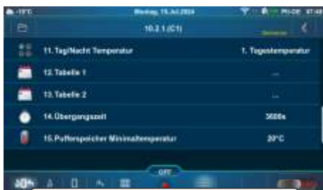
Heizung Typ - Heizkörper
