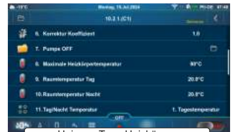
Heizung Typ - Heizkörper
