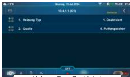
Heizung Typ - Deaktiviert
