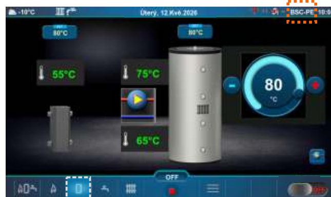
Obrazovka akumulární nádrže (BSC-PE)
