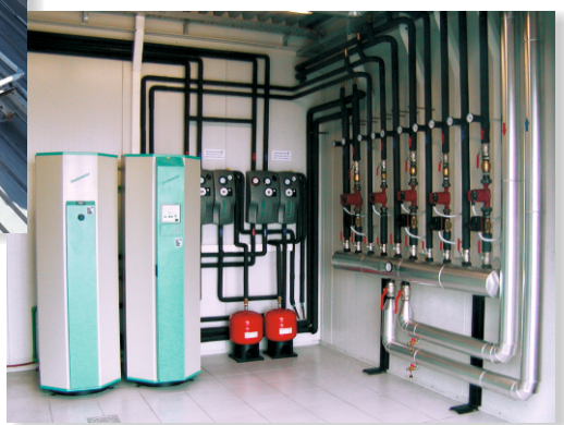
Primjer ugrađenog edukacijsko/pokaznog solarnog sustava s dva odvojena kruga kolektora (pločastim CPK 8203N 4H i cijevnim CVSKC-10), jednim solarnim bojlerom STEB i jednim akumulacijskim bojlerom TB, solarnim pumpnim grupama, kotlom te svom potrebnom armaturom.
