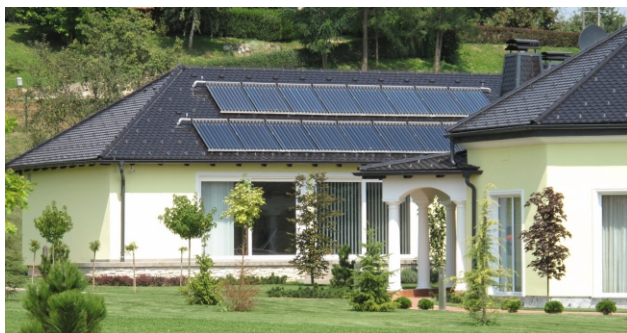
Primjer ugrađenog solarnog sustava za dogrijavanje sustava grijanja, sanitarne vode i vode bazena. Solarni sustav se sastoji od većeg broja cijevnih kolektora CVSKC-10, 2 akumulacijska spremnika s izmjenjivačem CAS-S, jednim solarnim bojlerom STEB-600, solarnom pumpnom grupom CSPG-260, kotlom na drvo Bio-Tec i plin EKO-CUP M3 te svom potrebnom armaturom.
