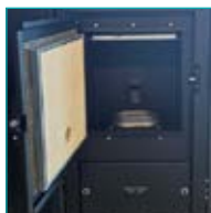
Ložište kotla
